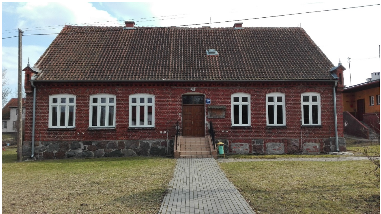
Rysunek 1 Budynek bylej szkoły w Rodnowie
