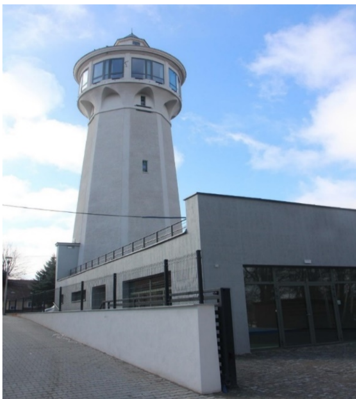
Wodociągowa wieża ciśnień po renowacji w 2020 roku
