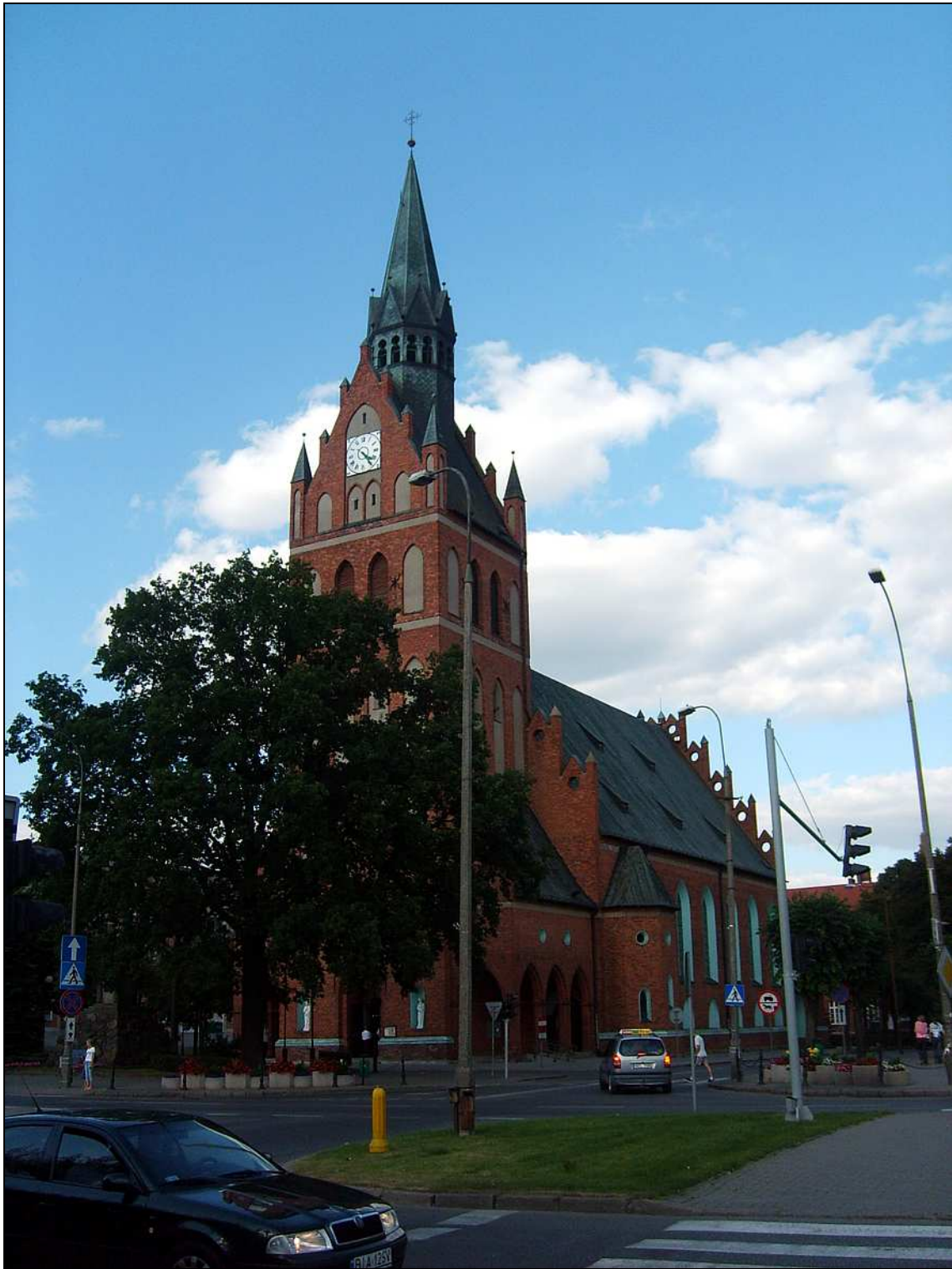
7. Widok na kościół pod wezwaniem Najświętszego Serca Jezusowego (poprzednio ewangelicki) – z 1847 roku. Fot. autor.
