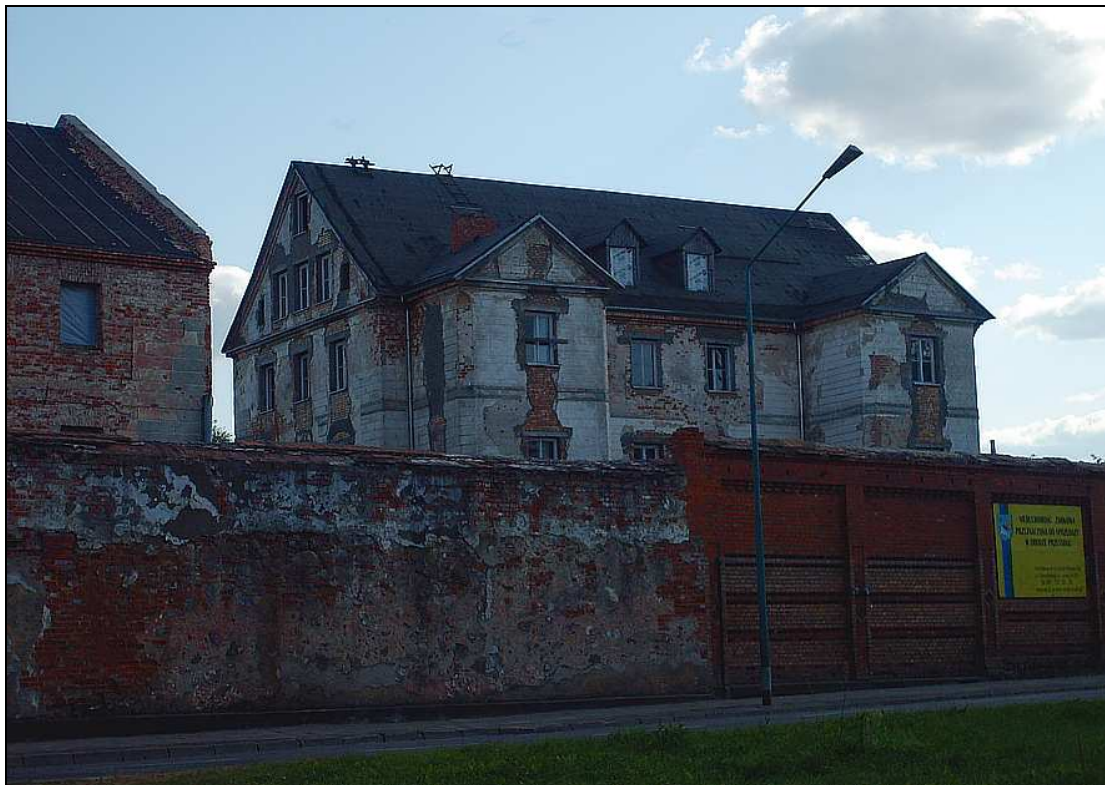
8. Widok na zamek prokuratorski pochodzący z przełomu XIV i XV wieku. Fot. autor.
