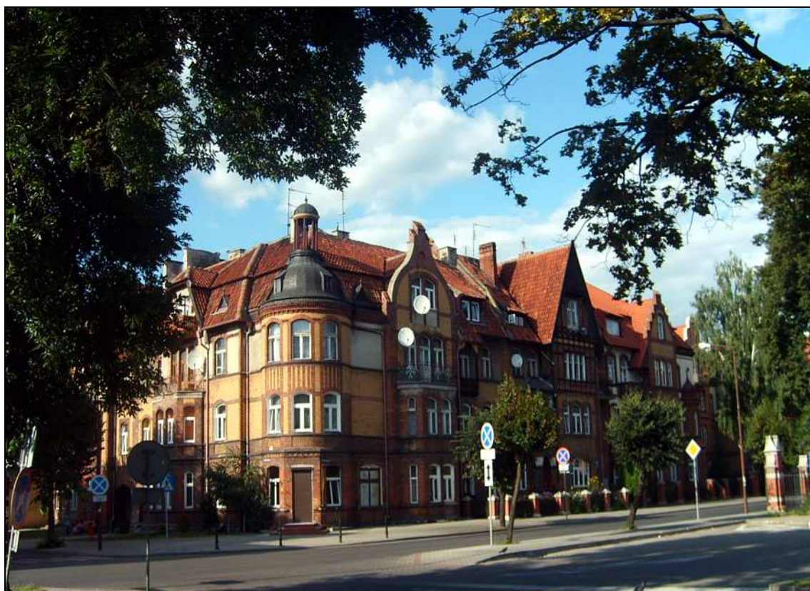
15. Widok ul. Kościuszki. Budynki z drugiej połowy XIX i początku XX wieku. Fot. autor.
